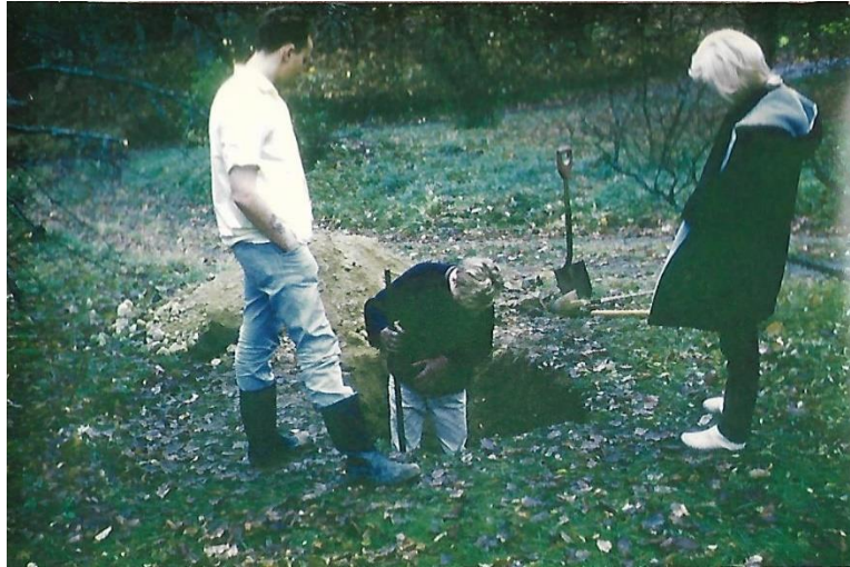
Första spadtagen för brunnsanläggningen, 1963
